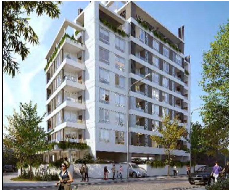
Area Herrera OBRA TERMINADA
