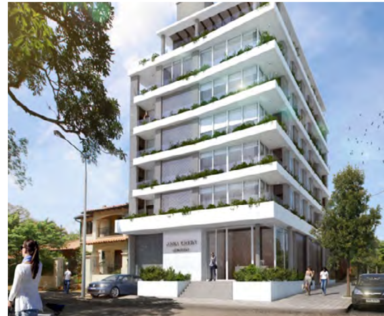
Area Green OBRA EN CONSTRUCCIÓN
